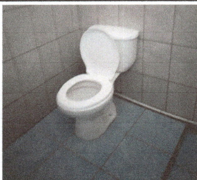
Foto 3: Vista de los servicios sanitarios reparados, con inodoros nuevos
