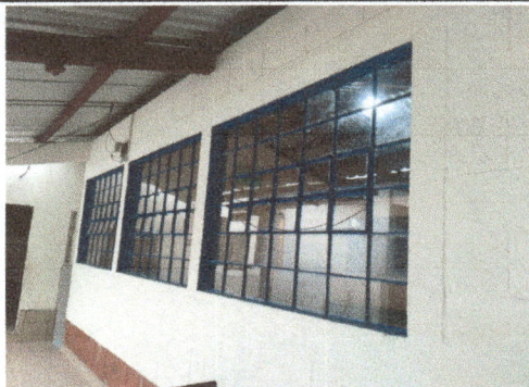
Foto 5: Vista de las ventanales reparadas
