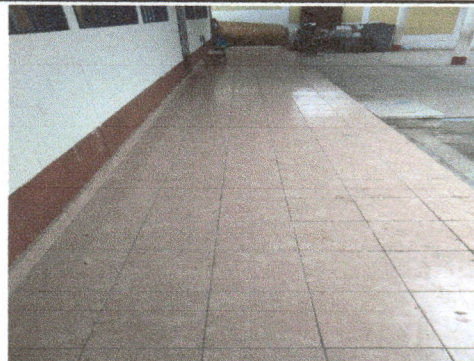
Foto 2: Vista del pasillo con nuevo piso cerámico
