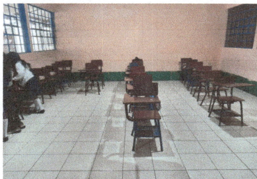
Foto 1: Vista del piso de las aulas con nuevo piso cerámico
